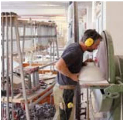
Gefühlssache: Einpassen des Waschbeckens
